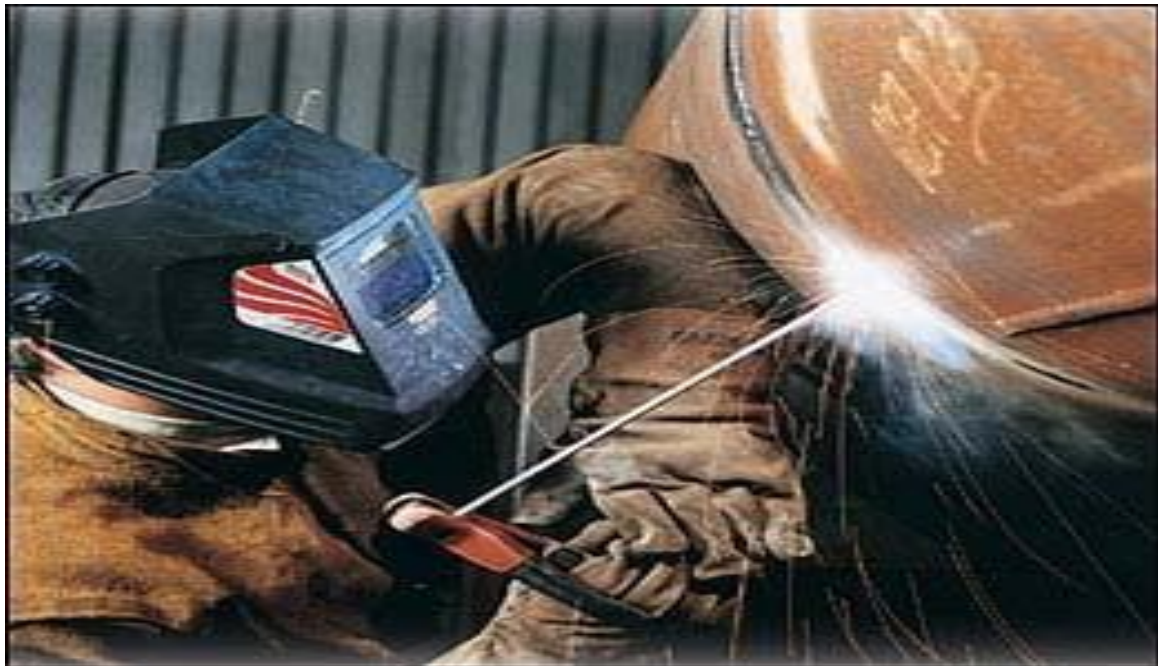
Figure I.3 : Le soudage à l'arc électrode.
