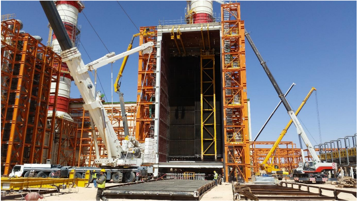
Figure II-11 : chaudière de récupération horizontale .
