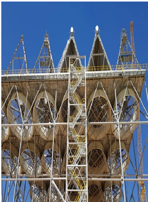
Figure I-14 : Aérocondenseur.
