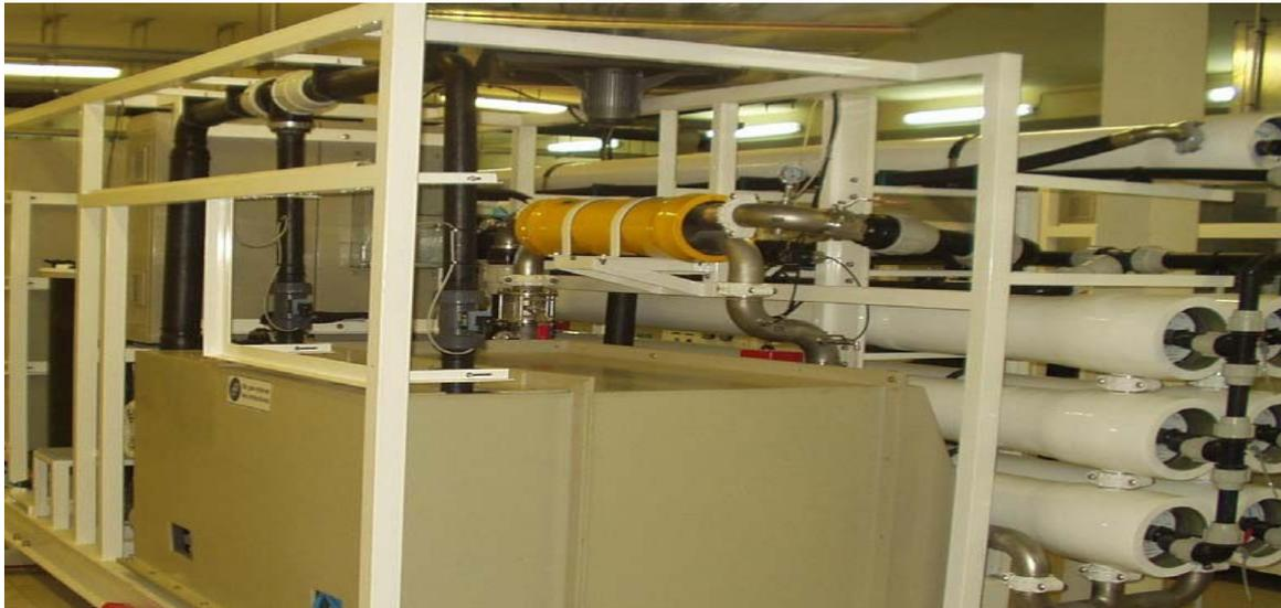
**Fig14:** Echangeur de pression dans une installation de système membranaire
