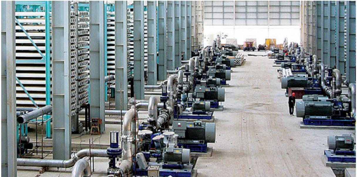
**Fig15 :** Les différents compartiments d'osmose inverse dans la station de dessalement de Mektaa
