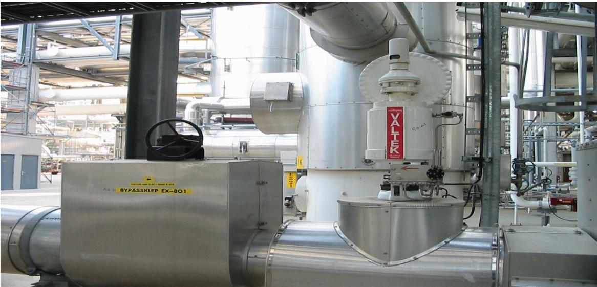
Figure III.13 : model d'une vanne de Joule Tompson
