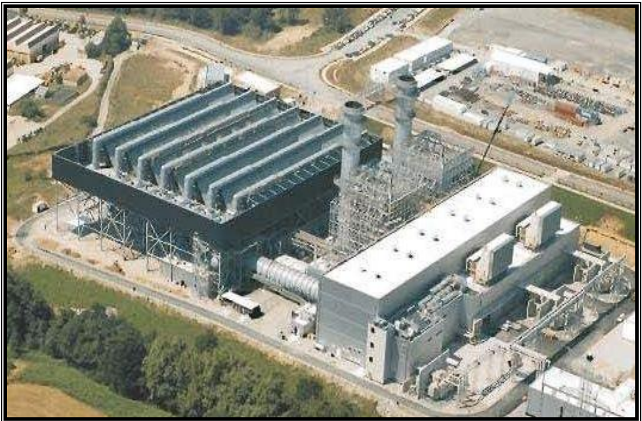
Figure o I.16 :aérocondenseur
