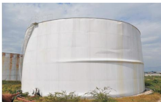
Figure 3. Flambement plastique
