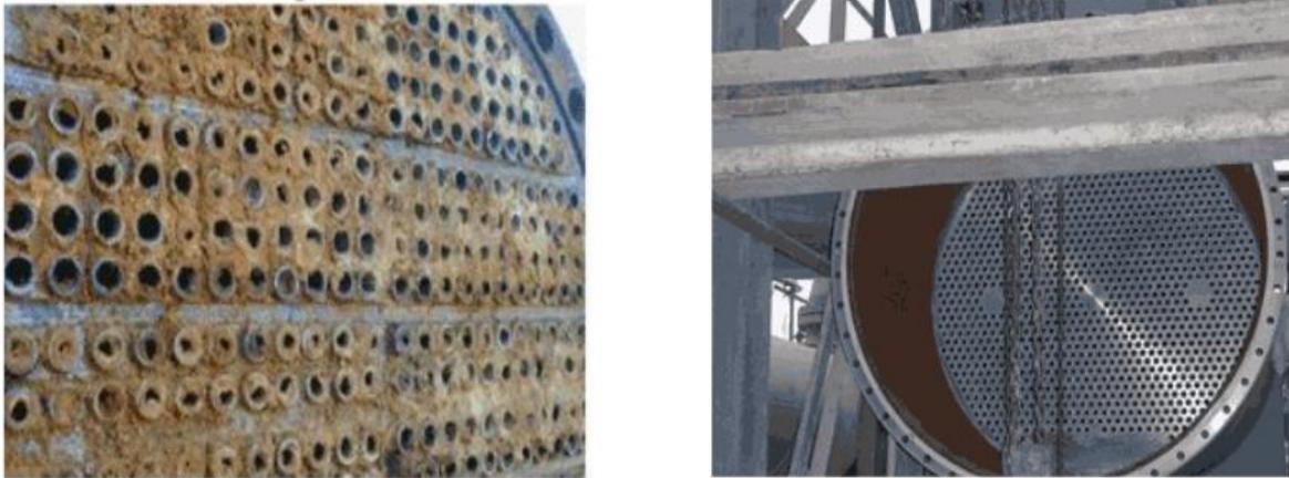
**Figure II.14:** Echangeur propre (à droite) et échangeur sale (à gauche)
