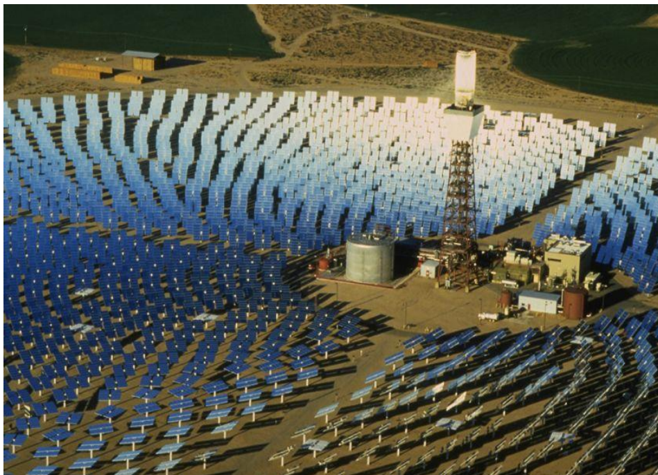
Figure I. 16 : Les centrales à tour.
