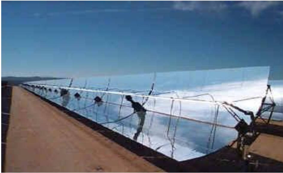
Figure I. 15 : les collecteurs cylindro-paraboliques.
