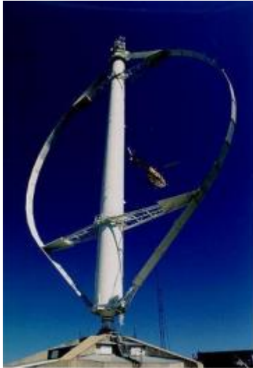
Éolienne de type Darrieus.
