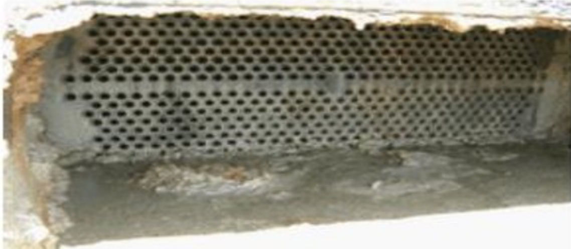
Fig. II.21 : Dépote de slime bactérien, hydrocarbures et oxydes métallique dans un échangeur de chaleur eau hydrocarbures (raffinerie de pétrole) [18]
