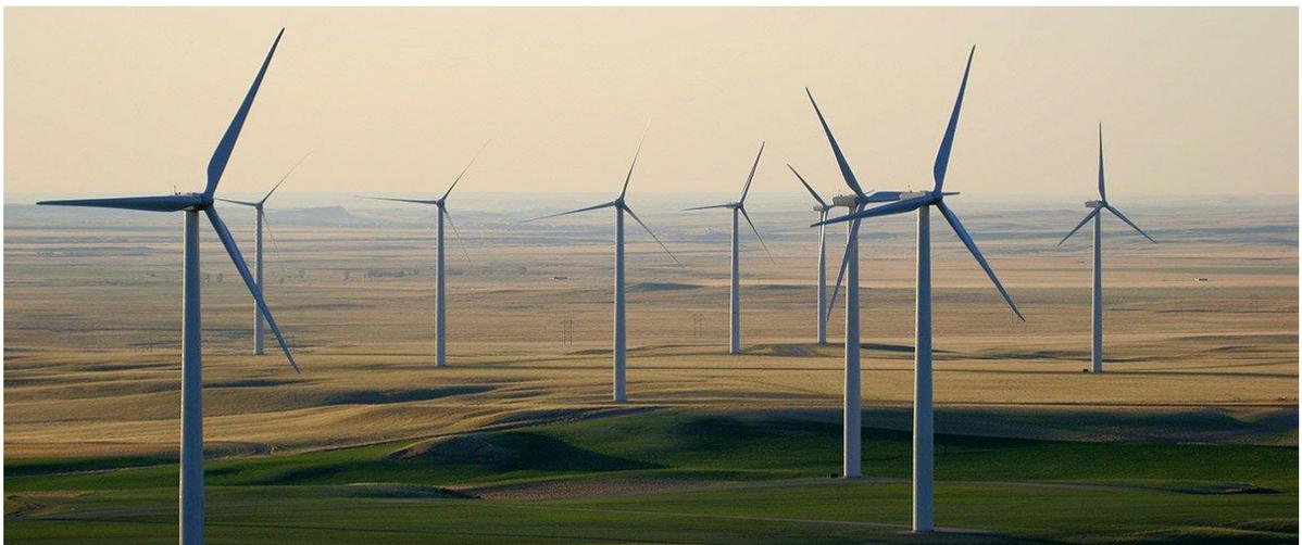
**Figure 1.3** : éolienne à axe horizontal
