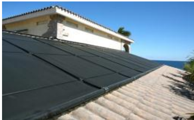
Figure I.15 : capteurs plans non vitrés utilisés pour le chauffage de l'eau de piscine.
