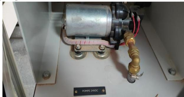
**Figure III. 7 :** Pompe de surface solaire.
