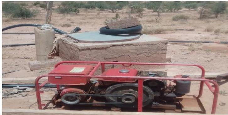
**Figure IV. 26 :** Groupe électrogène 5 KVA.
