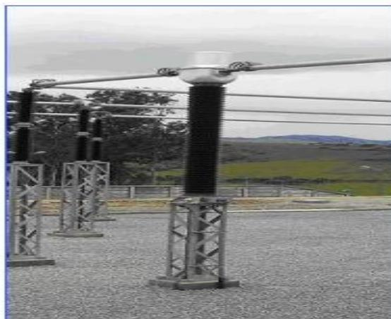
**Figure III-18:** Transformateur de courant [31]
