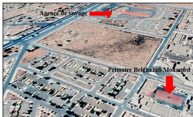
Figure IV.1 : Site de primaire Belghazali Mohamed.
