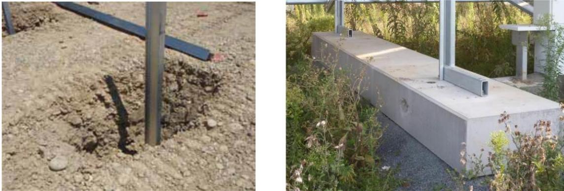
Figure.III. 9 Types de fondation - pieux battus (gauche) et semelle béton (droite)
