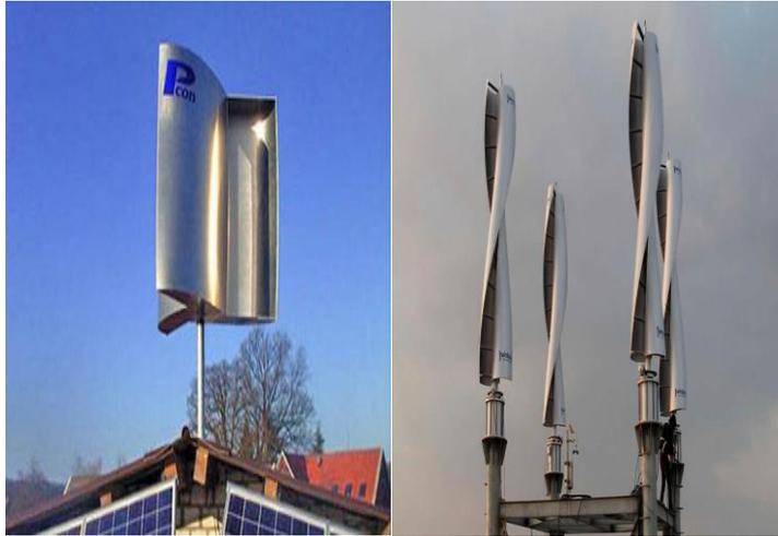
Figure I.12: Aérogénérateur Savonius [34].
