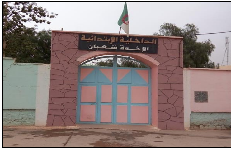
Figure 3.2 : la plateforme d'accueil du primaire les « frères Chaâbane »
